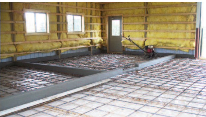
Vapor barrier laid and steel tied awaiting concrete pour
