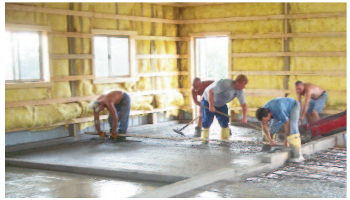
Pouring the floor
